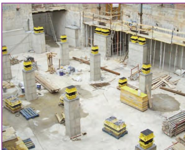
**VIB-3096** (amortiguador sobre pilares, utilizado en proyecto de suspensión antivibratoria del Edificio Teatro de Castelldefels)
